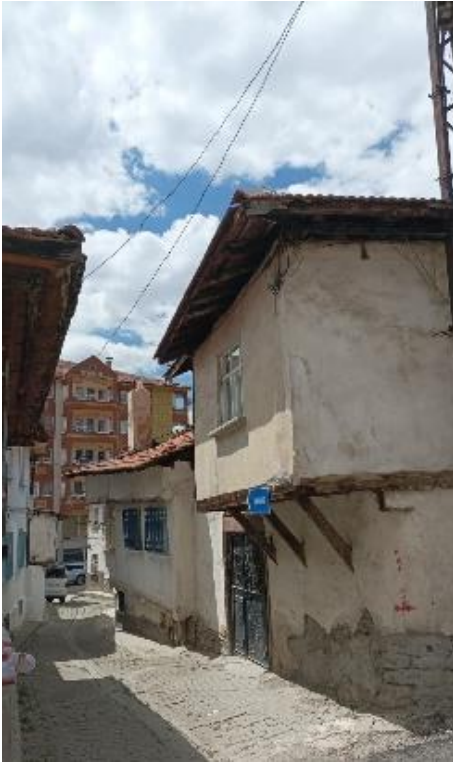
Şekil 1. Çankırı ili Mimar Sinan mahallesi, eski çankırı evi
