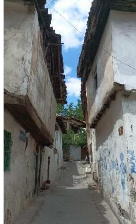
Şekil 2. Çankırı ili Mimar Sinan mahallesi, eski sokak
